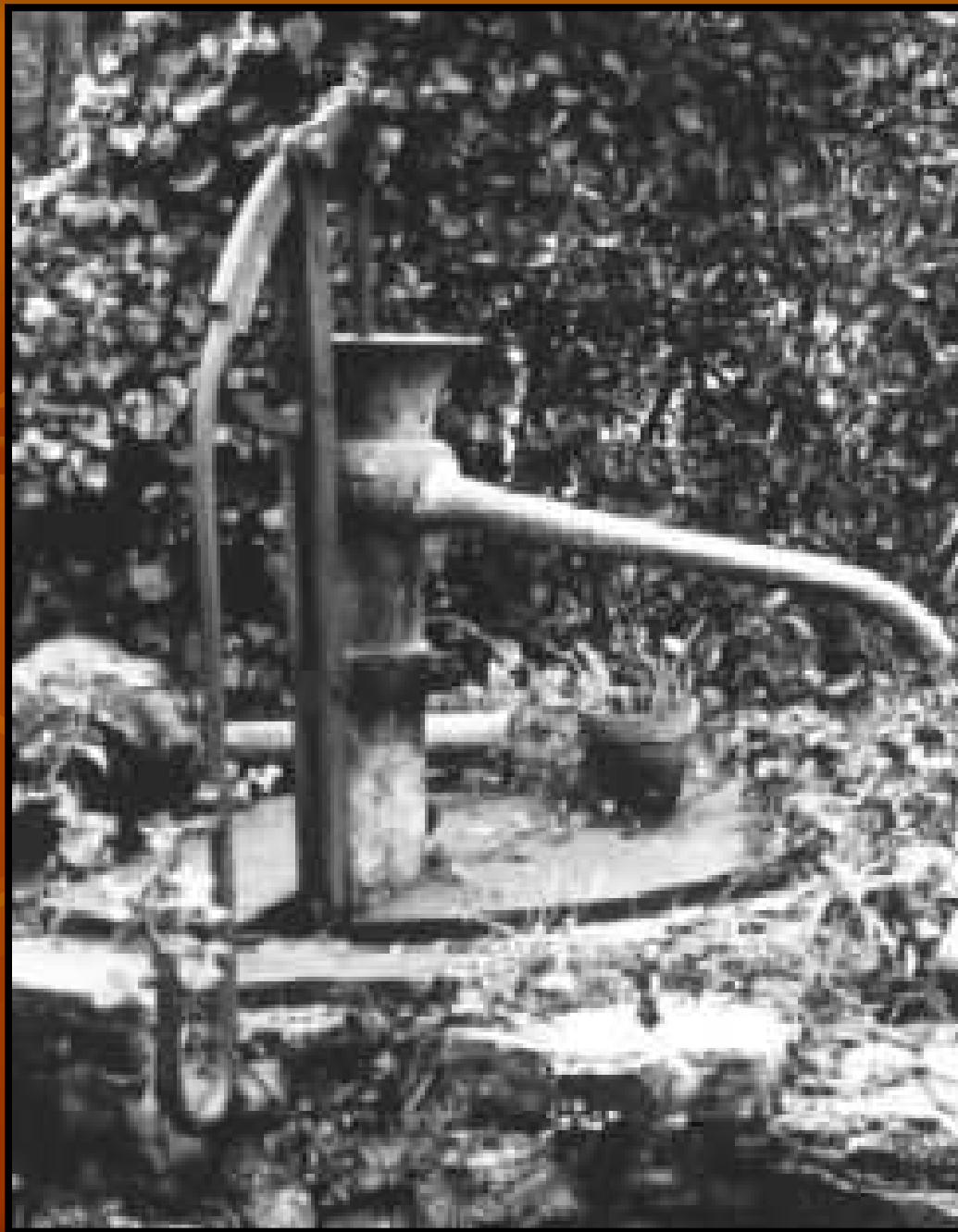
Pompe sur le puits (7)
